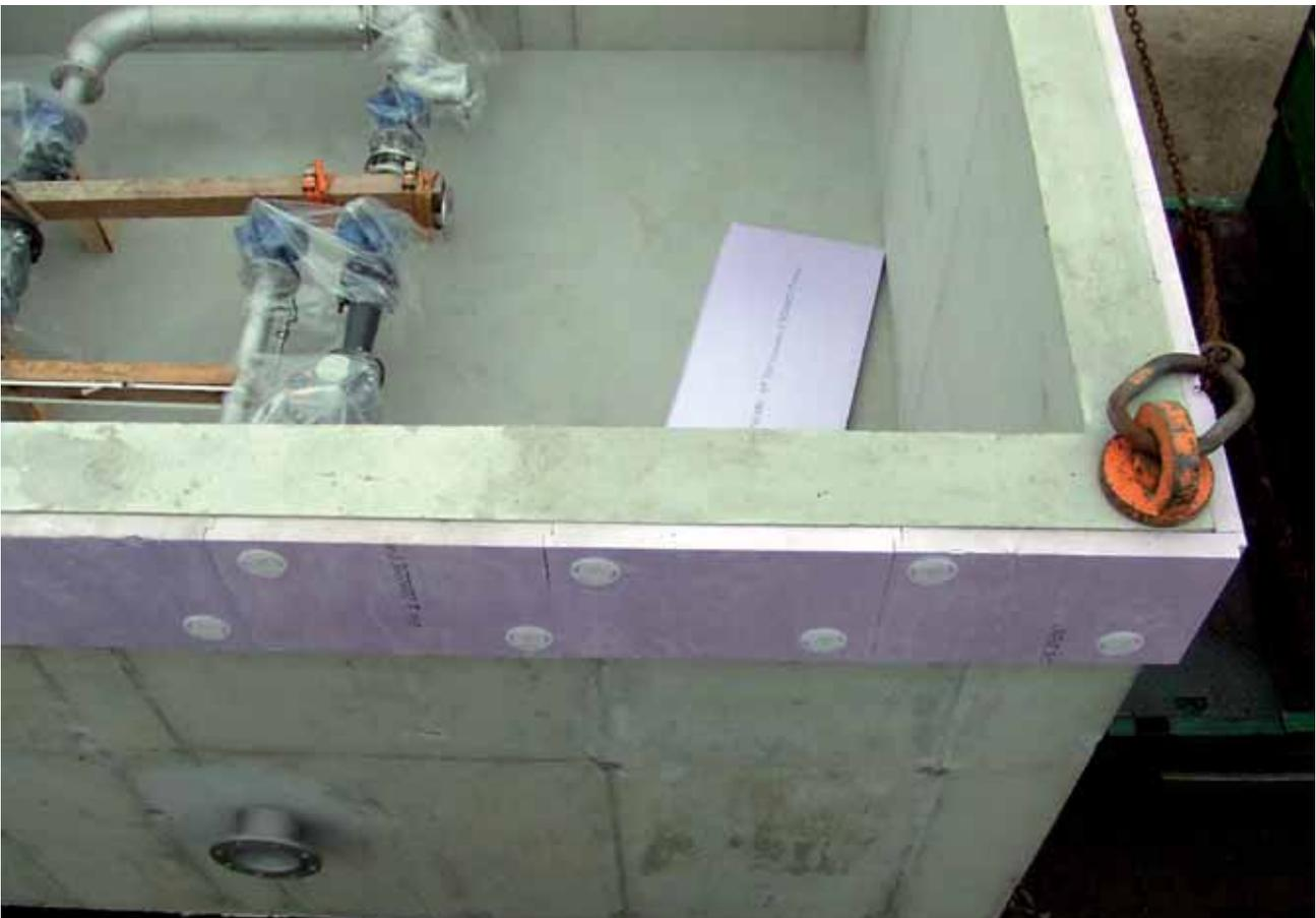
Schachtkörper mit Rohrleitung, Mauerflansch und Wärmedämmung
