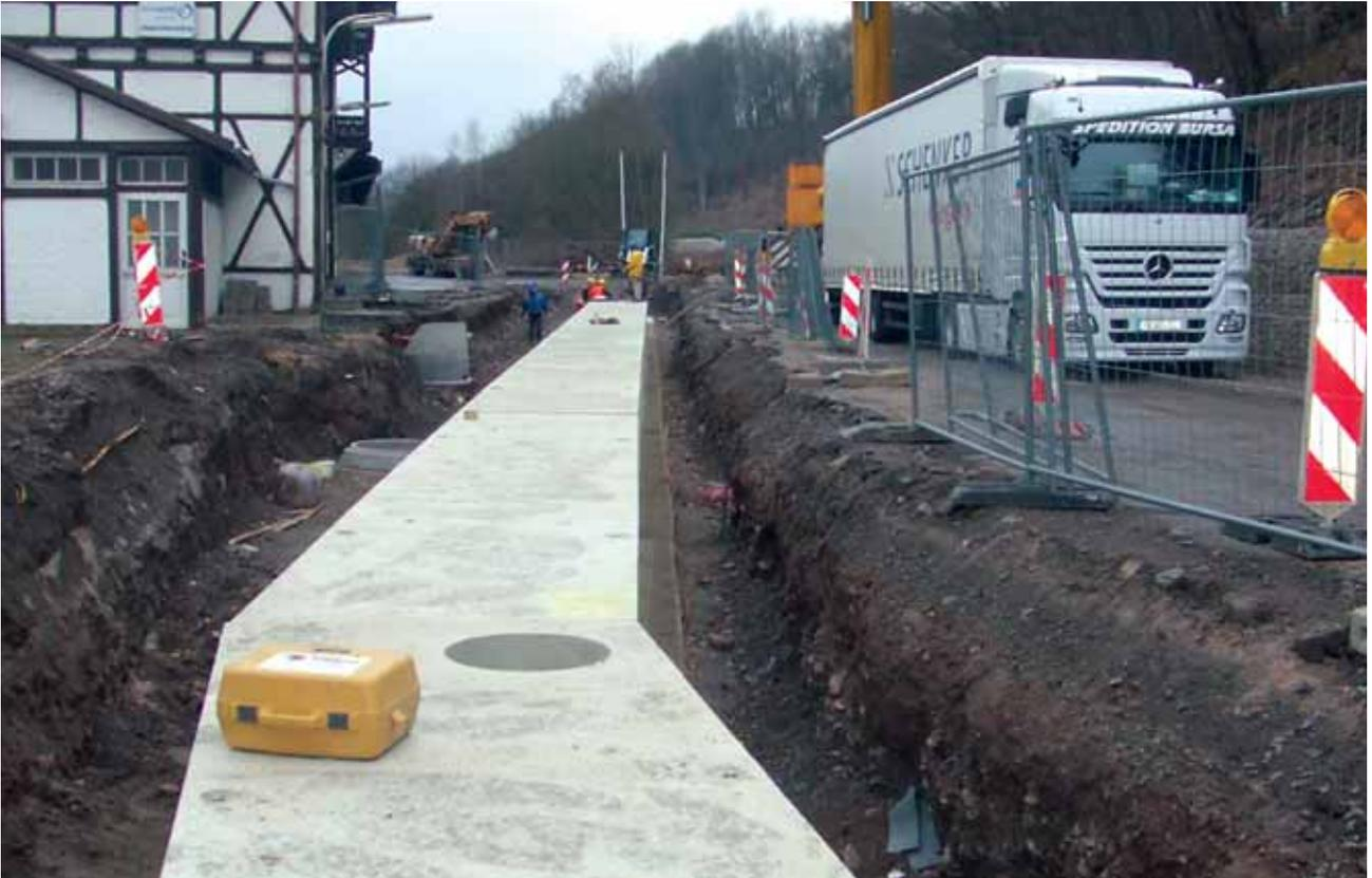
Bereits verlegte Rahmenelemente mit Krümmung und Einstiegsöffnung
