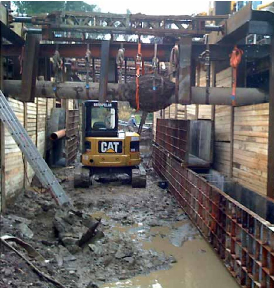
Erstellen der Baugrubensohle, Umleitung des Baches
