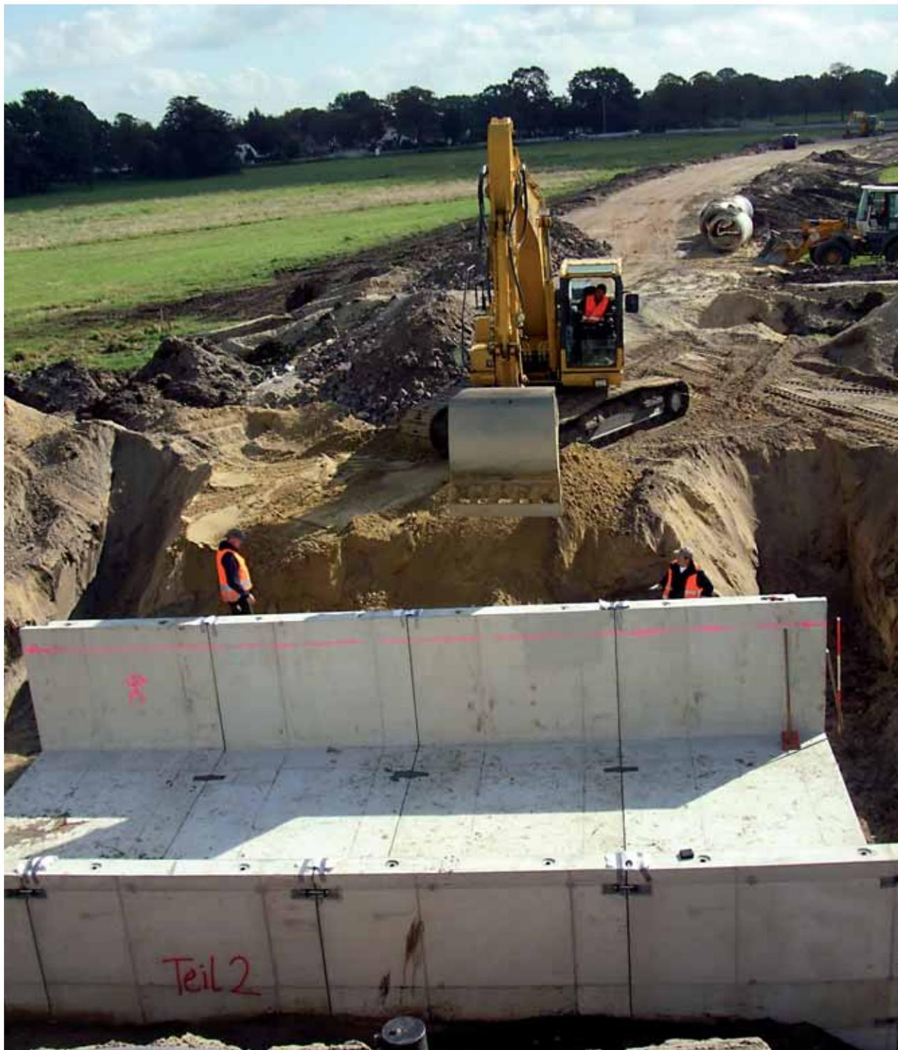
U-Teile eingebaut und druckwasserhaltend verspannt
