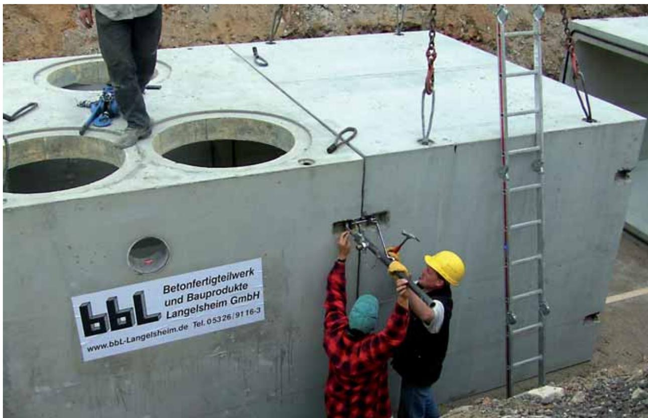
Druckwasserhaltende Verspannung der Rahmenelemente
