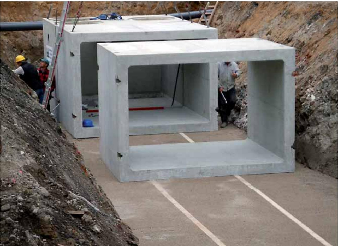
Setzen des Endteiles und der ersten Elemente auf vorbereiteter Baugrubensohle.
