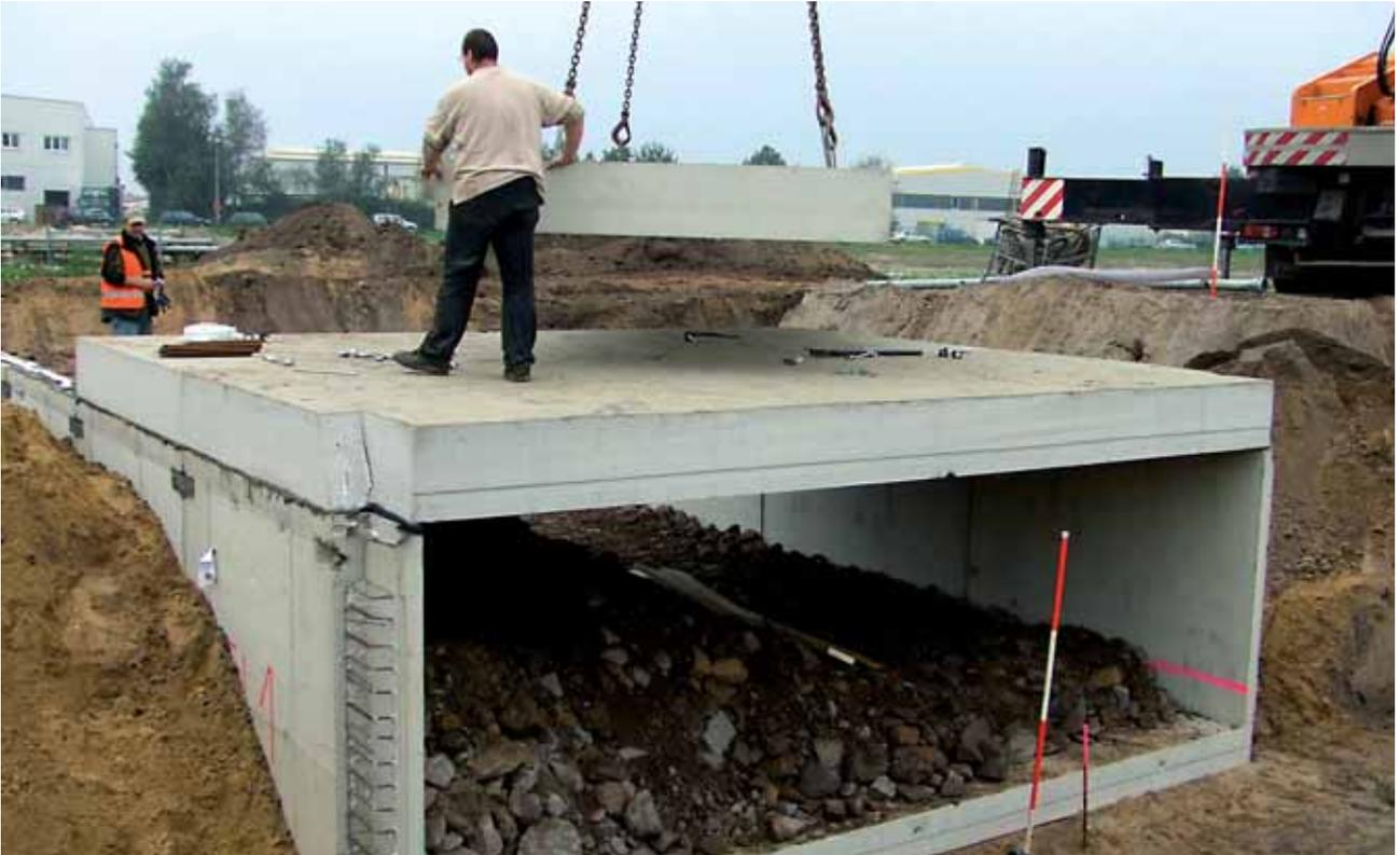
Montage der Deckenplatten druckwasserhaltend untereinander verspannt.
