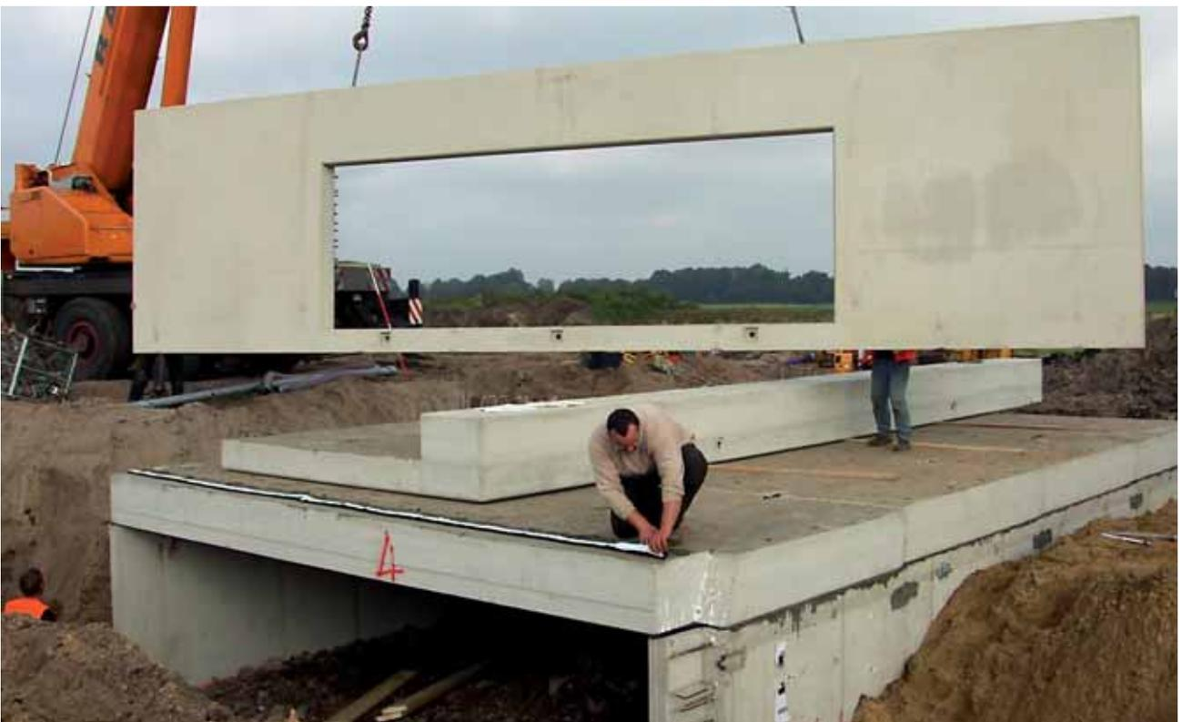
Montage der einteiligen Flügelwände mit angeformten Kappen
