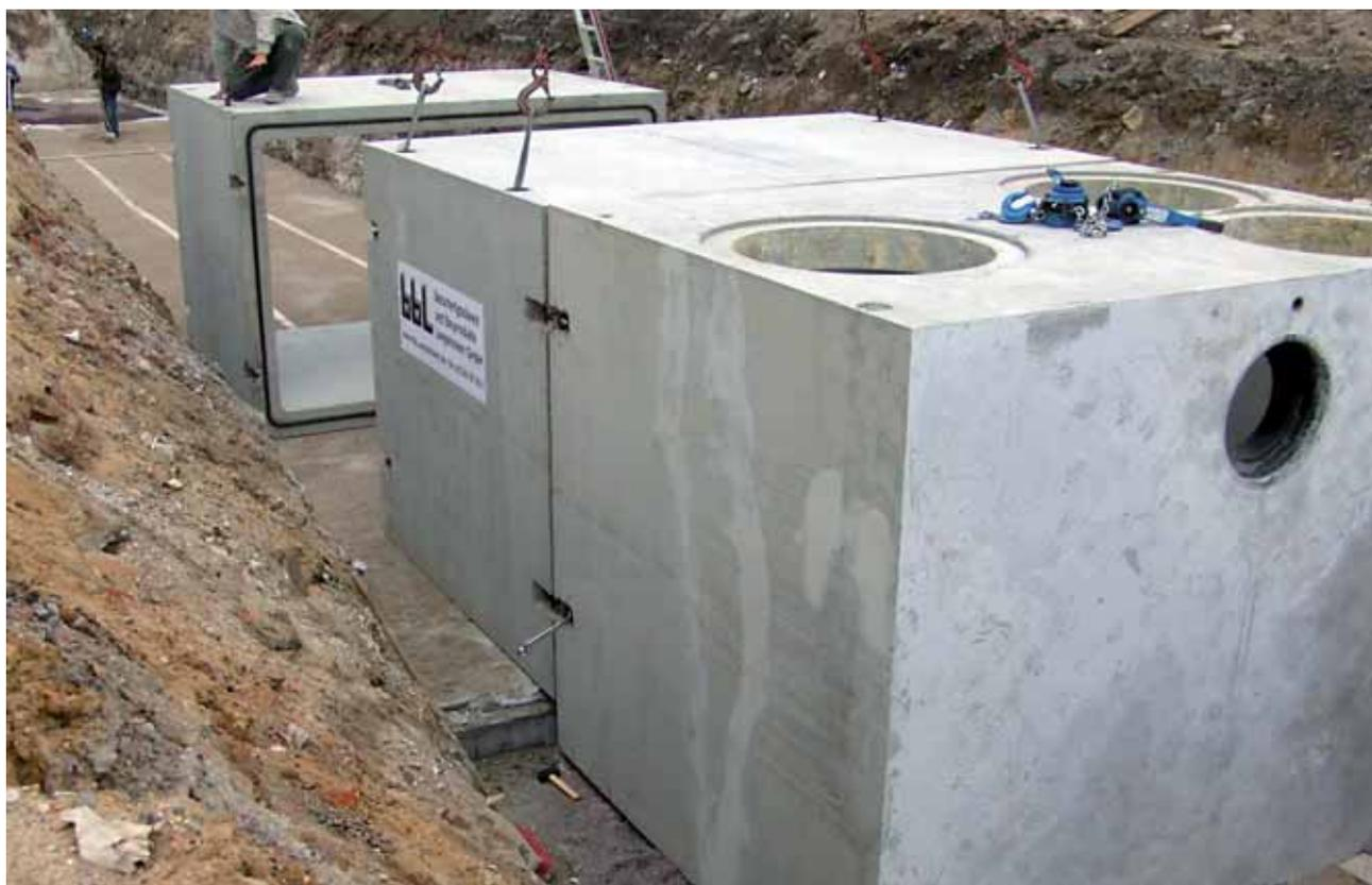
Vorbereitetes Rahmenelement mit aufgeklebter Dichtung
