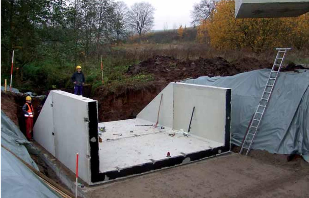
Einbau der U-Teile und Deckenplatten auf vorbereiteter Baugrubensohle
