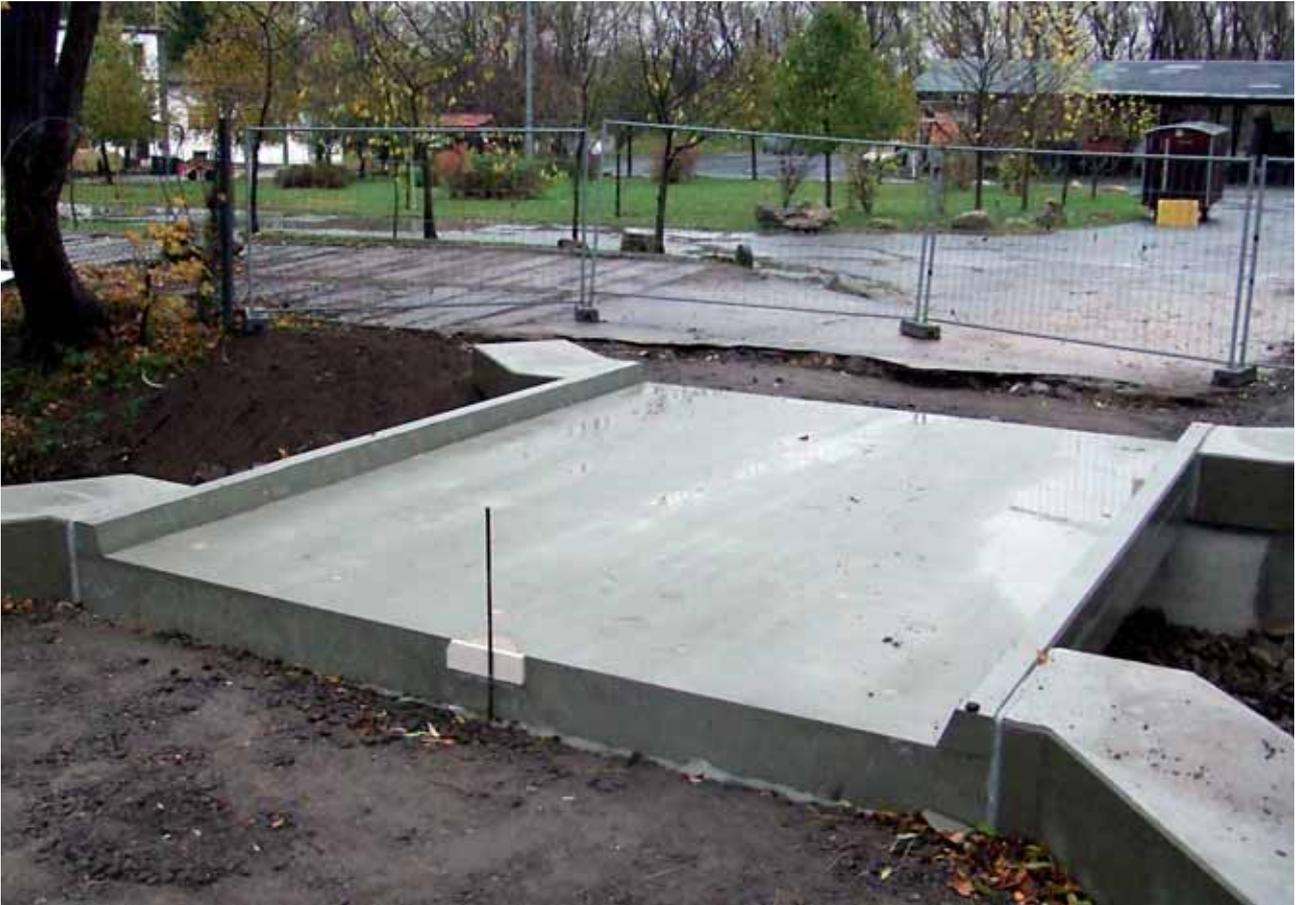
Brückenfertigteil auf Ortbetonfundament gelagert
