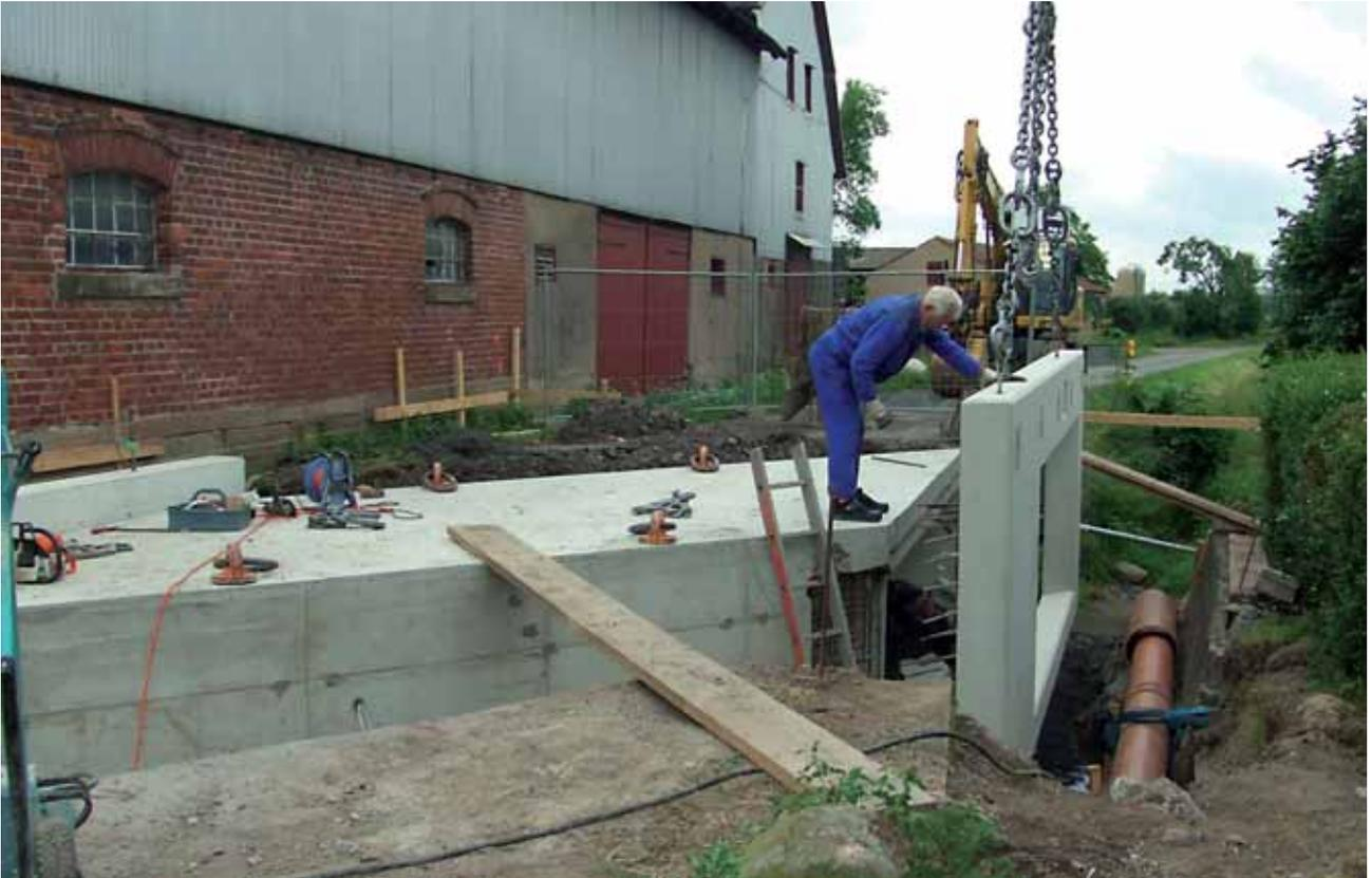
Einfädeln der zweiten Flügelwand auf das Rahmenteil,
