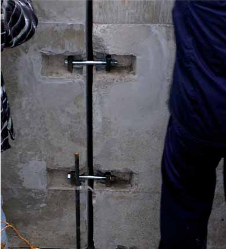
Beide Teile mit Spannschraubensätzen verbunden
