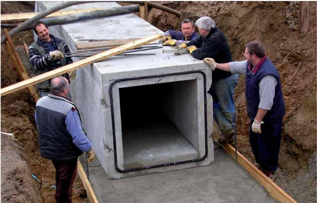
Ausgerichtetes Bauteil mit aufgeklebter Dichtung nach DIN 4060
